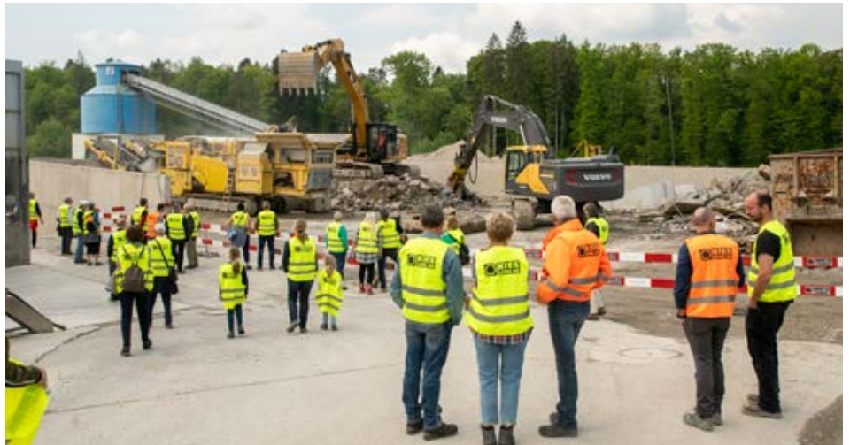
Betonbrecher bei der Arbeit: Besucherinnen und Besucher konnten vor Ort miterleben, wie altes Betonmaterial mit dem Betonbrecher zu kleinstem Material verarbeitet wird.
