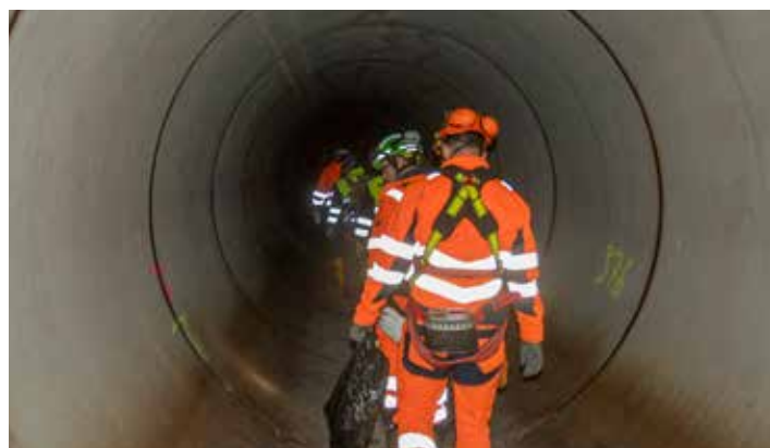
Gut sichtbar gekleidet, mit Helm und Taschenlampe ausgerüstet, wird jeder Laufmeter des Stollens genau begutachtet.
