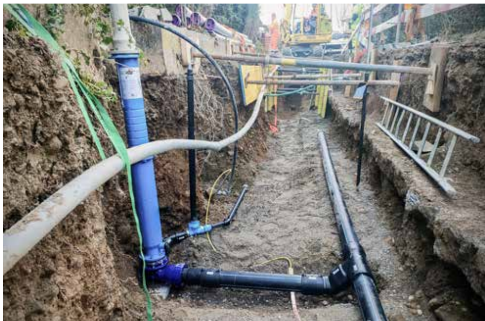
Aktuelle Baustelle Friedmatt mit Werkleitungsarbeiten. Das Bild zeigt eine Wasserhauptleitung mit einem Abgang zum Hydranten (helles Rohr ist das Hydrantenunterteil).
