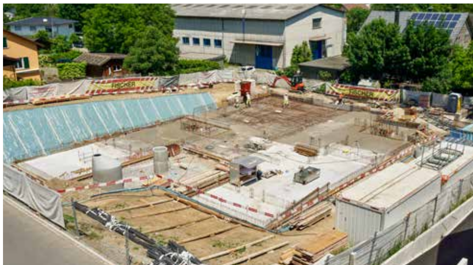
Der Baustart erfolgte Mitte März, aktuell ist die Bodenplatte fertig betoniert und alle Arbeiten liegen im Plansoll.
