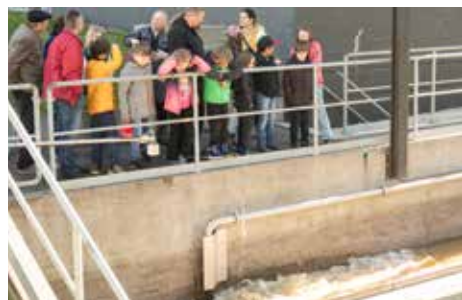
Im Kanal zur ersten Reinigungsstation sieht und schmeckt man, wie stark das Wasser verunreinigt ist.
