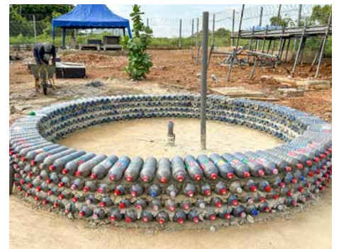
Das «Fundament» für den ghanaischen Aquaponikprototypen steht.
