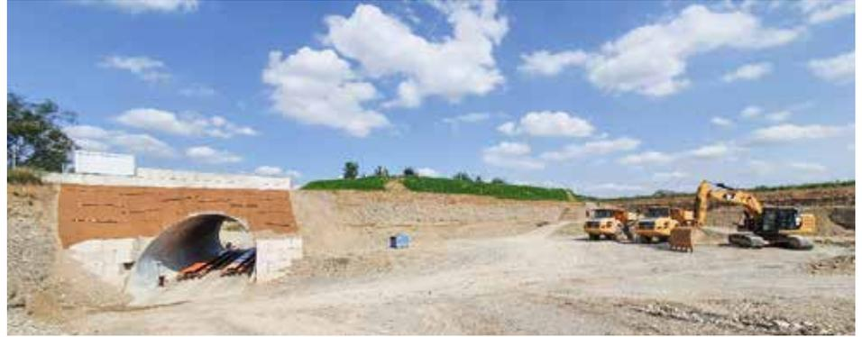
Kies wie auch das rückgeführte Aushubmaterial wird durch den Tunnel geführt, ohne Spazierende und Radfahrende zu gefährden oder zu behindern.
