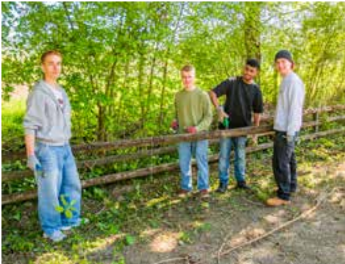
Für eine neue Abschränkung am Parkplatz bei der Hundehütte waren Ivan, Tim, Arangan und Leo unter der Leitung von Martin Meier zuständig.
