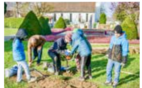
Gemeinsam im Team werden die Erdbohrungen für die Kastanienholzpfähle, die das Turmgerüst bilden, bewältigt.
