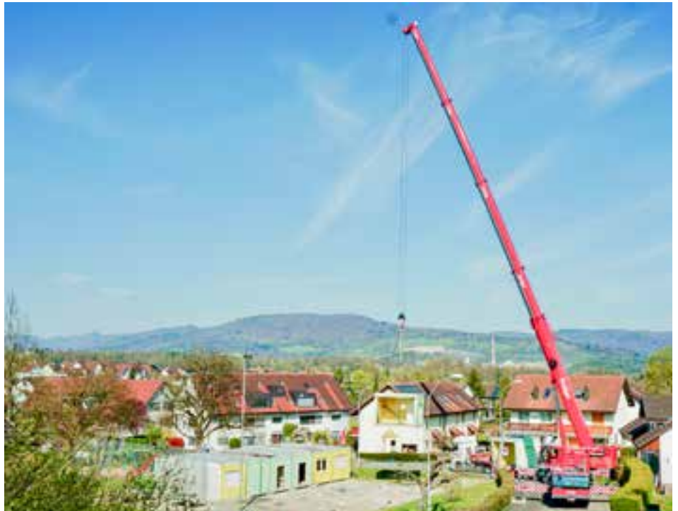
Präzise hob der riesige Pneukran Container um Container vom Areal ab und platzierte diese für den Abtransport passgenau auf den bereitstehenden Camions.
