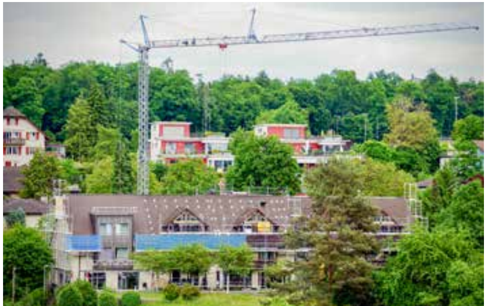
Schon von weitem ist die «Grossbaustelle» beim Alterszentrum Hungeligraben zu sehen.
