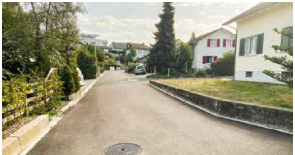
Baustelle an der Friedmatt abgeschlossen.
