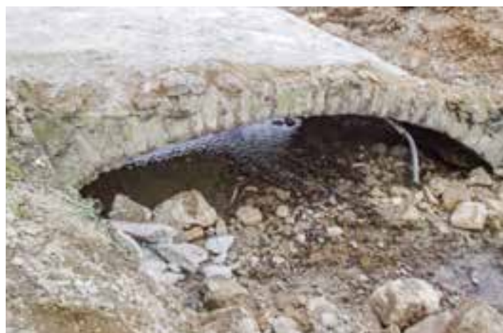
Die «steininen Bruggen» wurde am Freitag, 29. November 2013 abgebrochen, jedoch die Fundamentsteine aus Jurakalk konnten zum Teil an ihrem Standort belassen werden. Foto: Willi Bürgi
