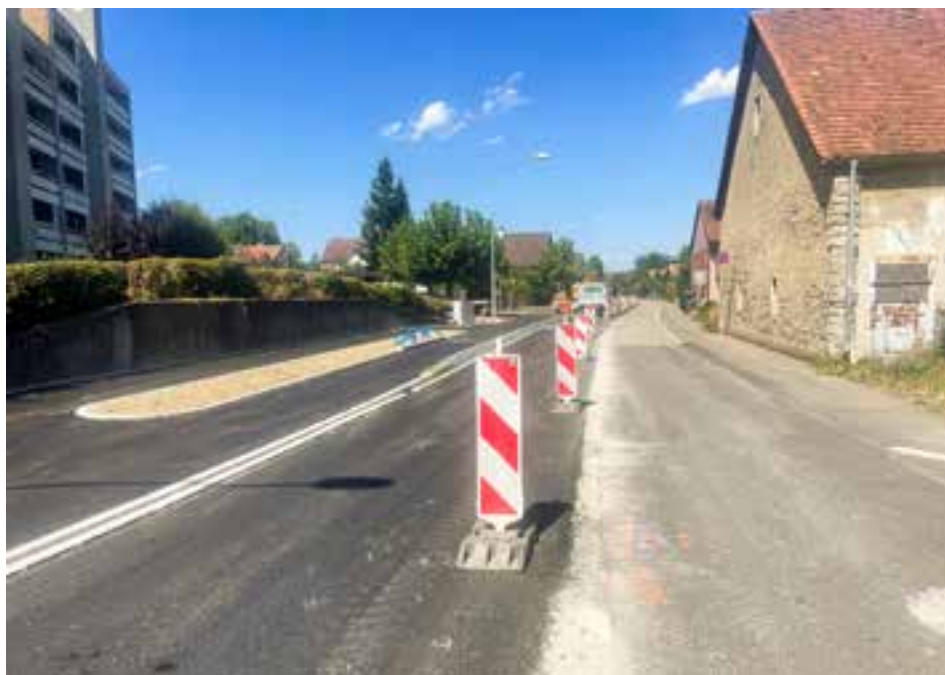
Sanierung der Staufbergstrasse ist im Zeitplan.
