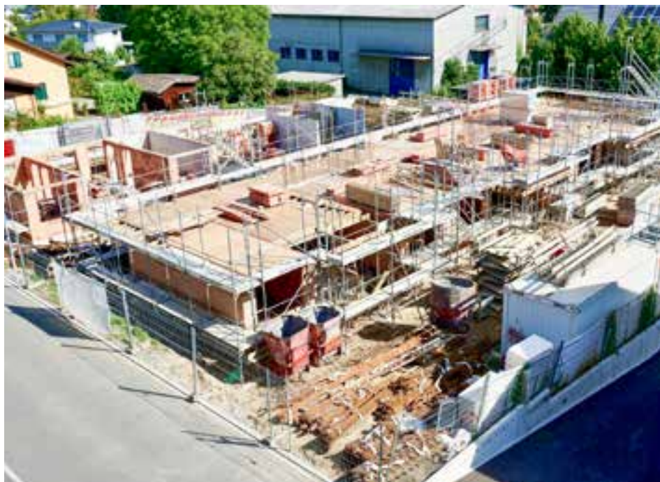
Übersicht der aktuellen Grossbaustelle «Eichi» Ende August 2026.
