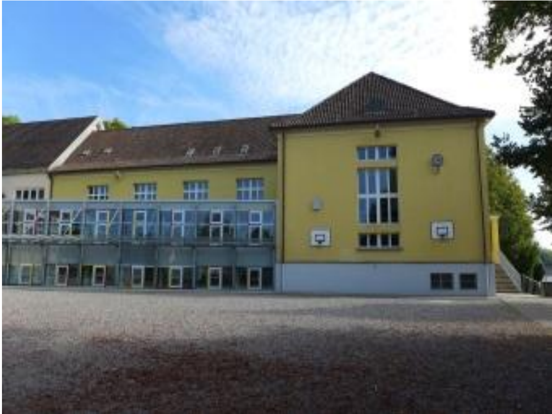
Abbildung 98: Kernbau des Schulhauses Rotbleicherain mit nordseitigem Anbau
